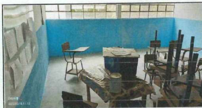
Foto 6: Aula 2 Modulo 1. Se observa que el piso es de torta de concreto líquida. Por lo cual se le instalara piso cerámico.
