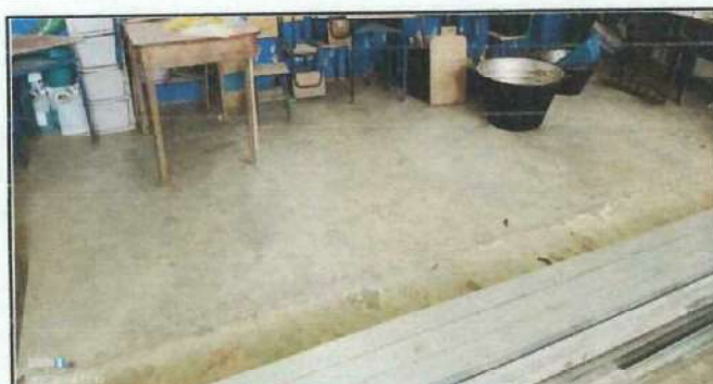
Foto 4: Aula 4 Modulo 2. Se observa que el piso es de torta de concreto líquida. Por lo cual se le instalara piso cerámico.
