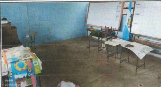
Foto 2: Aula 6 Modulo 3. Se observa que el piso es de torta de concreto líquida. Por lo cual se le instalara piso cerámico.
