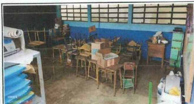
Foto 3: Aula 5 Modulo 2. Se observa que el piso es de torta de concreto líquida. Por lo cual se le instalara piso cerámico.
