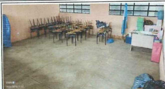
Foto 1: Aula 7 Modulo 3. Se observa que el piso es de torta de concreto líquida. Por lo cual se le instalara piso cerámico.
