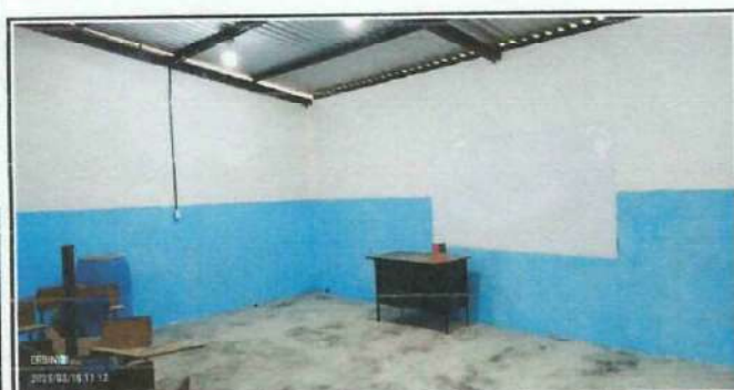
Foto 5: Aula 3 Modulo 1. Se observa que el piso es de torta de concreto líquida. Por lo cual se le instalara piso cerámico.
