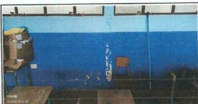
Foto 5: Aulas 4 y 5 Modulo 2. La pintura interna de las aulas se encuentra en mal estado debido al uso que se le ha dado.
