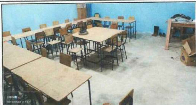
Foto 1: Aula 1 Modulo 1. Se observa que el piso es de torta de concreto líquida. Por lo cual se le instalara piso ceramico.
