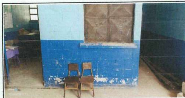
Foto 6: Bodega escolar. Se observa el mal de la pintura interno y externo, debido al clima y al uso del edificio.
